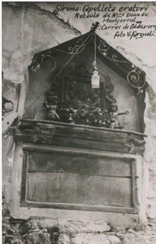
Figura 1. Mare de Déu de Montserrat . Fotografia antiga de la capella al carrer dels Calderers. Font: Ajuntament de Girona, CRDI, Valentí Fargnoli, RG 092798.
