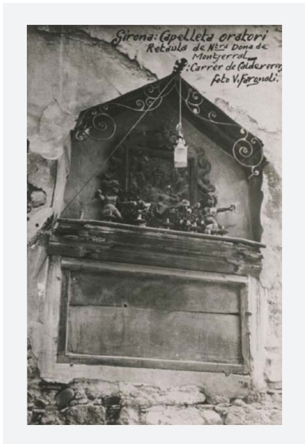
Figura 1. Mare de Déu de Montserrat . Fotografia antiga de la capella al carrer dels Calderers. Font: Ajuntament de Girona, CRDI, Valentí Fargnoli, RG 092798.
