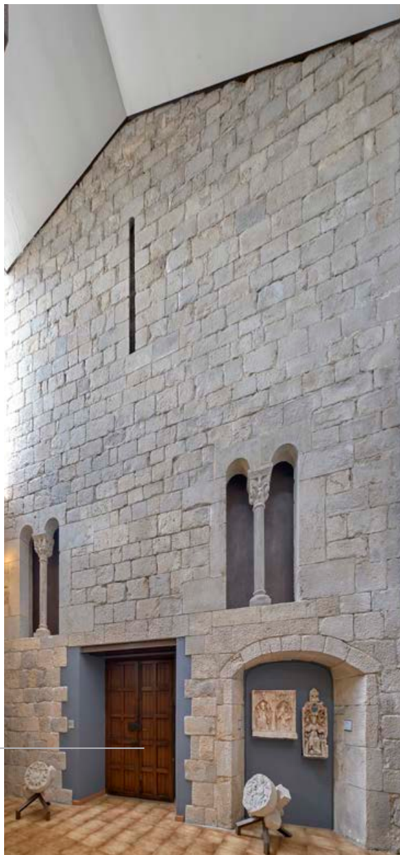
Antiga façana sud del Palau Episcopal
